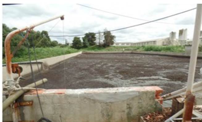
Figura 9 - Tanque de retenção (Foto da visita em 12/04/2021)
