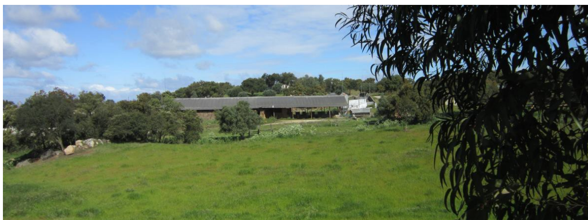
Figuras 3 - Infraestruturas associadas ao núcleo de bovinos (Figuras 3 e 4 do EIA)
